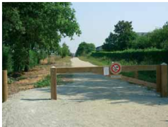
Une signalétique spécifique (panneaux "B7B") doit être mise en place pour interdire l'accès aux engins motorisés.
