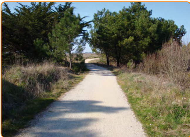
Voie cyclable littorale dans le massif dunaire de Gâvres-Quiberon : stabilisé sablé renforcé avec un liant minéral ( espace remarquable du littoral, site classé et site Natura 2000 ).
