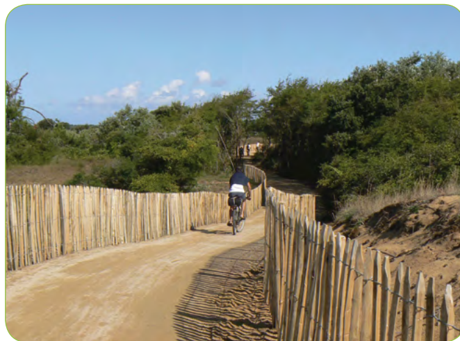
Dunes de la Sauzaie : canalisation et préservation de la dune par ganivelles
