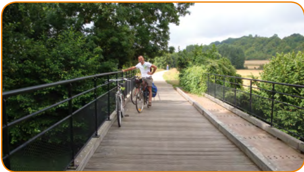
Franchissement de la vallée de l'Epte. Pont réservé à la voie cyclable, aménagement d'un ouvrage de l'ancienne voie ferrée. Site classé
