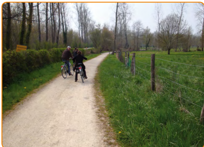
Marais poitevin, aménagement des chemins ruraux traditionnels : grave calcaire compactée, matériau local adapté aux caractéristiques et variations hydriques du sol (site classé, site Natura 2000, secteur régulièrement inondé).
