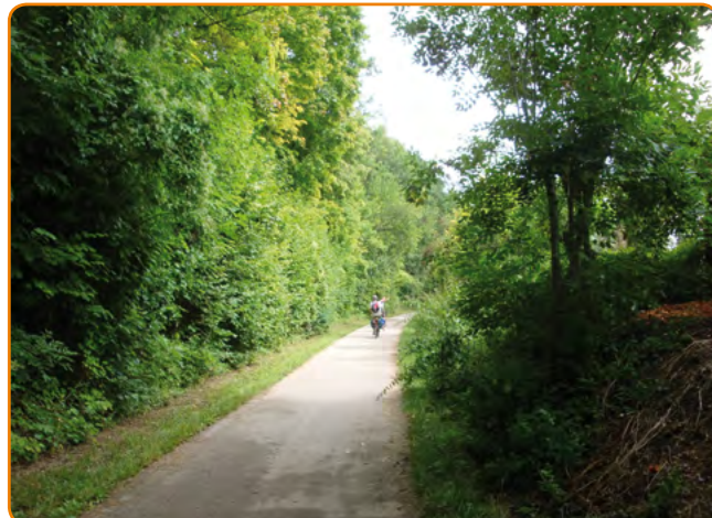
Voie verte de la vallée de l'Epte, réalisée sur une ancienne voie ferrée en fond de vallée : choix d'un enrobé clair coulé à froid. Très roulant, faible entretien et bonne intégration paysagère.
