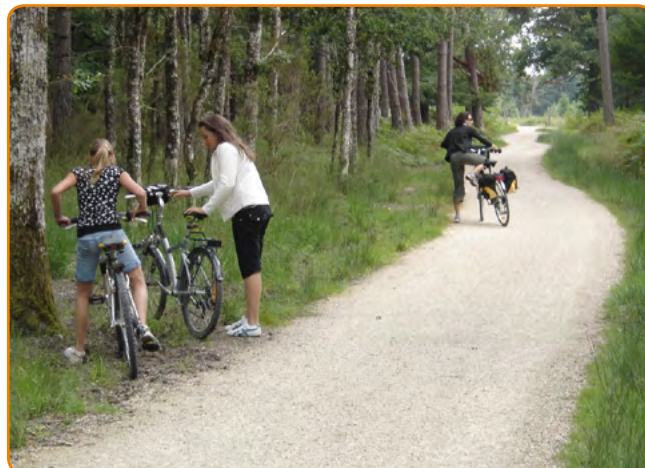
Parc de Chambord : dans et aux abords du parc, intégralement en site classé, choix d'un stabilisé calcaire, sorte de béton calcaire réalisé avec des matériaux d'une carrière proche (Grave des Minières).
