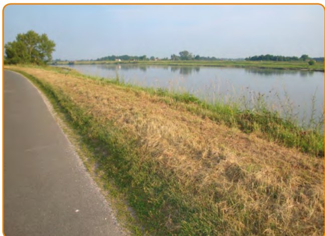
Voie cyclable sur une levée de Loire, dans la campagne agricole : choix d'un enrobé classique gris, en accord avec les services assurant l'entretien des digues et levées. L'enrobé classique peut être une bonne solution, à condition de limiter drastiquement la largeur, supprimant ainsi l'effet routier.
