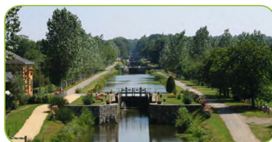
Échelle d'écluses de Hédé
