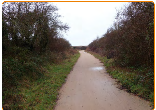
Milieu dunaire en Vendée : revêtement en sable compacté sans liant, qui se révèle résistant dans la durée bien roulant, compact, et à faible entretien ( espace remarquable du littoral, site classé et Natura 2000 ).
