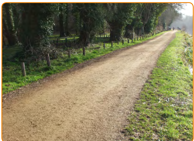
Niort : voie cyclable réalisée le long de la Sèvre niortaise en sable stabilisé à liant pouzzolanique, lui conférant un aspect de chemin de terre et une bonne roulabilité.
